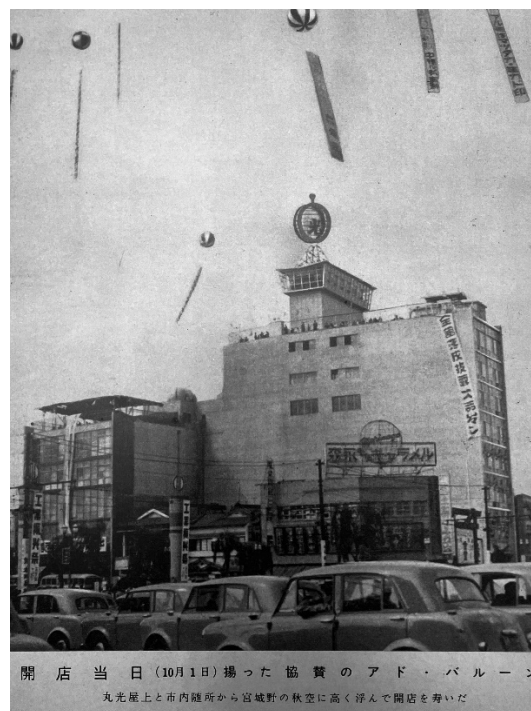
Fig. 3 屋上にドームを持つ丸光デパート （資料提供：NPO 法人 20 世紀アーカイブ仙台）
