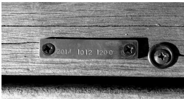
Fig.4 新しく用意したネジと日付刻印用プレート
